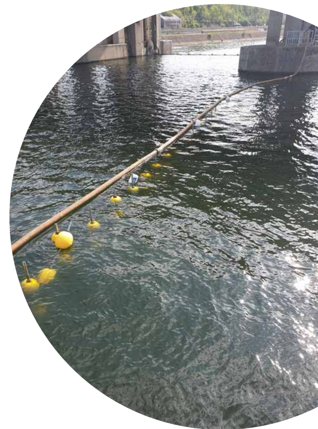
Installatie van de elektrische afstotende barrière stroomopwaarts van de waterkrachtcentrale van Grands-Malades.
