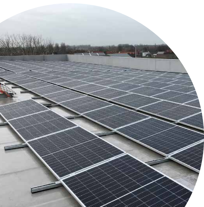
Een deel van een dak van de werkplaatsen op de site van Isomo.
